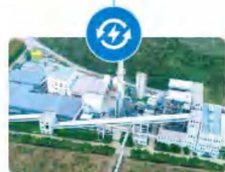
浙江华和热电有限公司 Zhejiang Huahe Thermo Power CO., LTD
